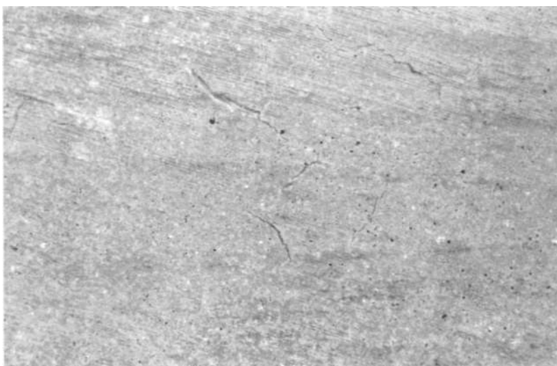
slika 8. Tragovi četke po svježoj žbuci
