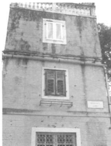
slika 4. i 5. Primjeri slijepih sljubnica na pročeljima
