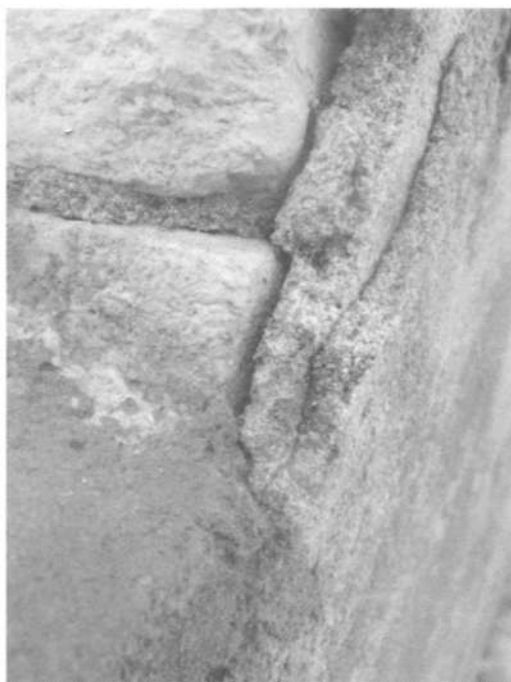
slika 6. Žbuka u sljubnici između dva kamena segmenta
