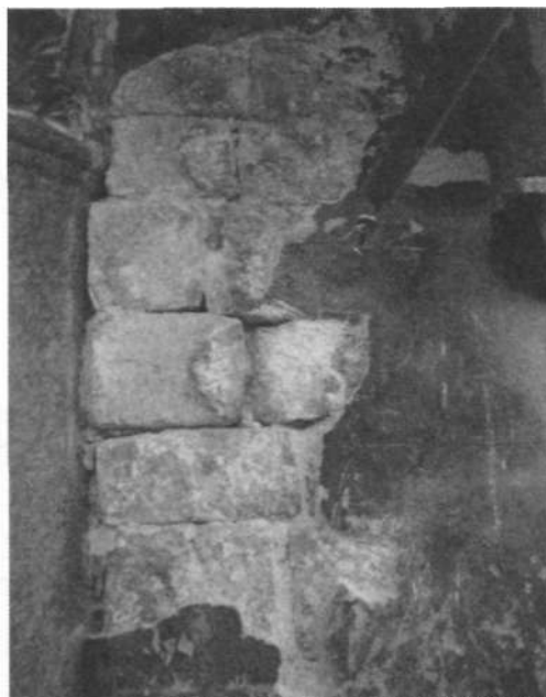
slika 9. Grubo klesani kameni segmenti kojima je ispunjen prostor između dva stupa kolonade
