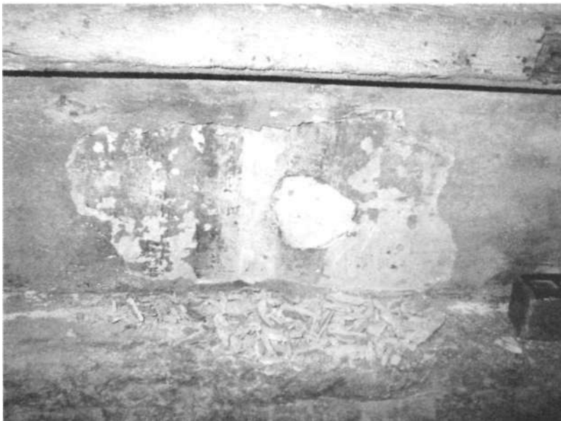
slika 7. Tragovi prijašnjih bojanih slojeva žbuke
